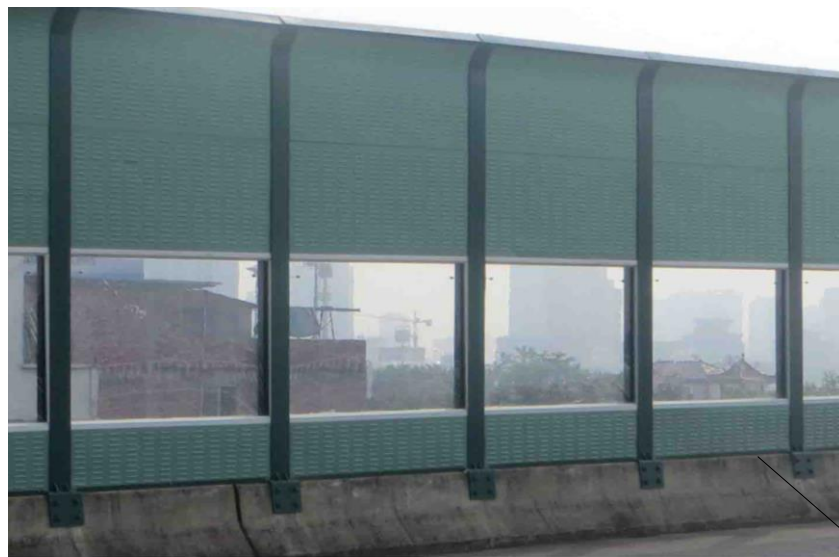
图 5.11-2 声屏障底部连接实景图
