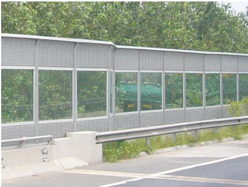
图 5.10-2 声屏障过渡段结构实景图
