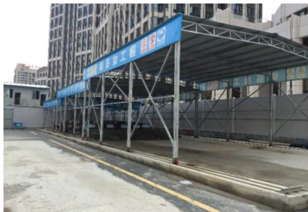
半封闭钢筋加工棚
