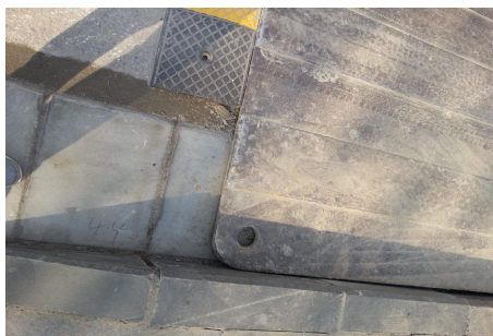
路面覆盖钢板
