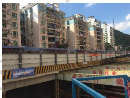
轨道交通占道工地隔声围挡
